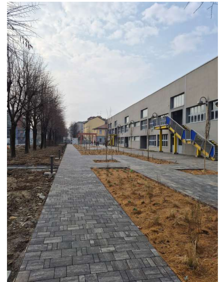
Fig. 38 - Intervento di de-impermeabilizzazione durante i lavori nel viale di accesso
